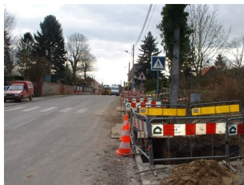
Des tranchées des 2 cotés de la route
