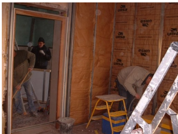
Travaux pendant la phase d'isolation
