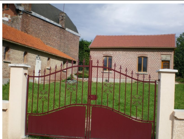
Une réhabilitation qui se remarque
